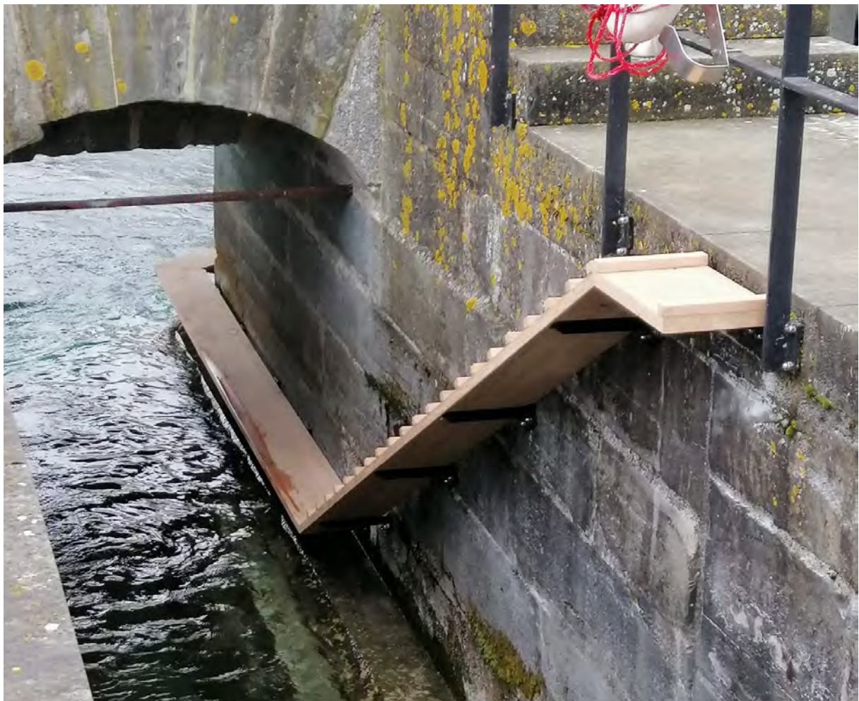
Abbildung 2: Für den Biber wird dank der hölzernen Rampe der Weg beim Kraftwerk Mühleplatz in Luzern frei. Foto: Pro Natura Luzern
